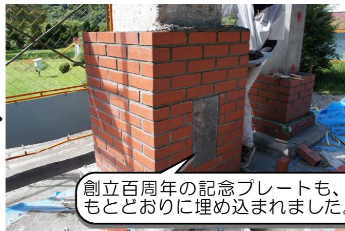
いよいよレンガの積み上げが、始まりました。1段ずつ手作業で行われます。
