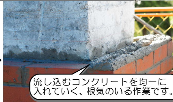
いよいよレンガの積み上げが、始まりました。1段ずつ手作業で行われます。
